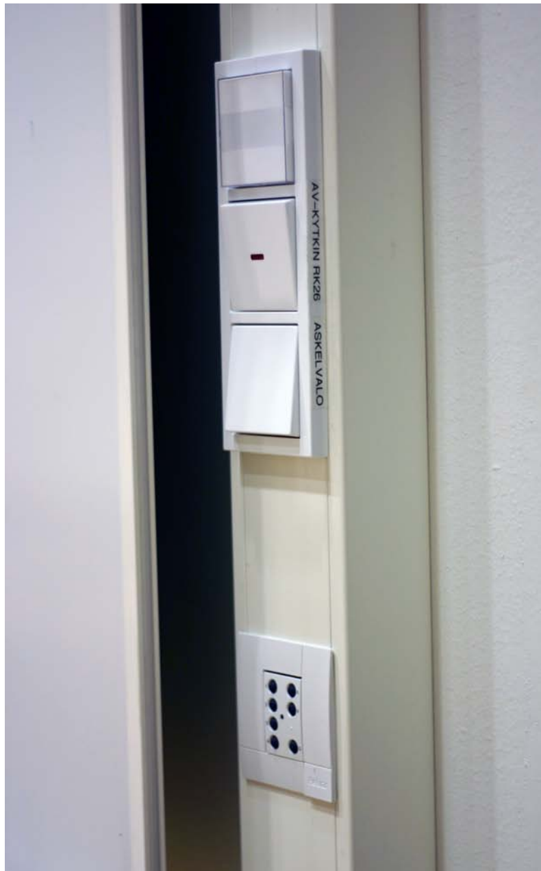
Kuva 23: Ovenpielen seinäpainikkeisto. Alareunassa näkyy valopainikkeisto, jonka vasemmassa reunassa on neljä valmiista valotilannetta ja oikeassa reunassa himmennuksen säädöt ja kaikkien valojen sammutus. Painikkeet on numeroitu, muttei nimetty, joten käyttäjillä on usein ongelmia sopivan valaistuksen löytämisessä. Ylenpänä näkyvät valkoisilla tarroilla nimetyt katkaisijat tilan kulkuvaloille, joita ei tutkimuksessa ole huomioitu, sekä järjestelmän pikasammutukselle. Sammutuspainiketta pitäisi painaa viisi sekuntia yhtäjaksoisesti, joten se on jäänyt käyttämättä.
