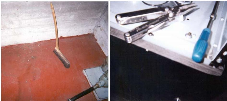
Kuva 3. Vasemmanpuoleisesta kuvasta pystyttiin tunnistamaan meneillään oleva huoltotyövaihe (hissikuilun puhdistus), mutta oikeanpuoleista kuvaa ei ilman kuvaajan haastattelua voitu yhdistää mihinkään tiettyyn huoltotyön osa-alueeseen tai tehtävään
