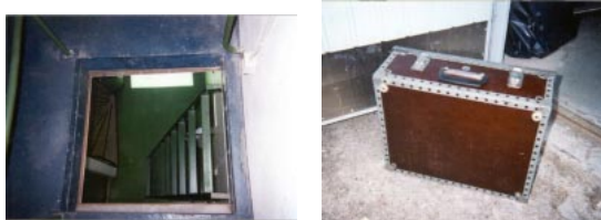
Kuva 14: Portaat konehuoneesta alas porraskäytävään. Työkalujen kuljettaminen tällaisia tikkaita pitkin on hankalaa. Joskus salkkua joutuu käyttämään portaana.
