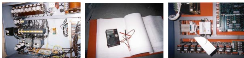
Kuva 13: Vanhaa hissitalua (vas.) voi korjailla hyppylangoin jännitemittarin avulla (kesk.). Oikealla uusi hissitalu. Releiden valot kertovat mm. ovien asennoista ja turvapiirien tiloista.
